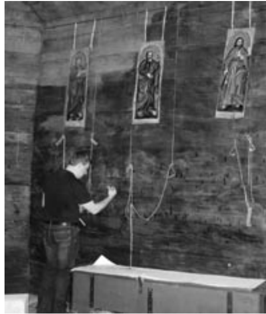
Процес укріплення та дезинсекції дерев'яних стін церкви Зішестя Святого Духа (1598) в Рогатині, 2007–2008 рр.
